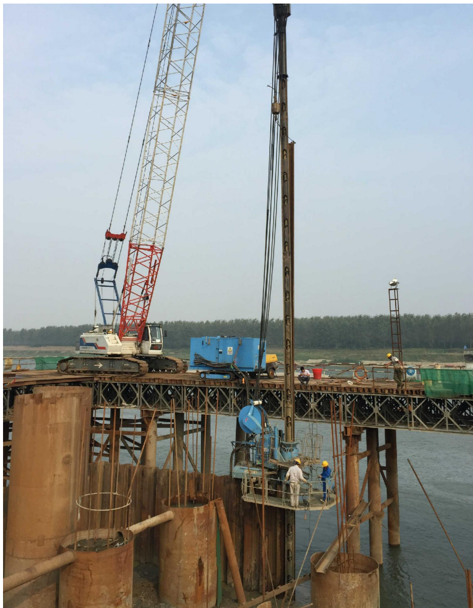
静压植桩机作业中
