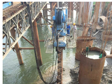
静压植桩机作业中
