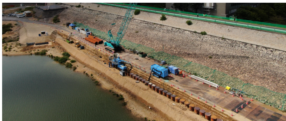
堤内側施工状況
