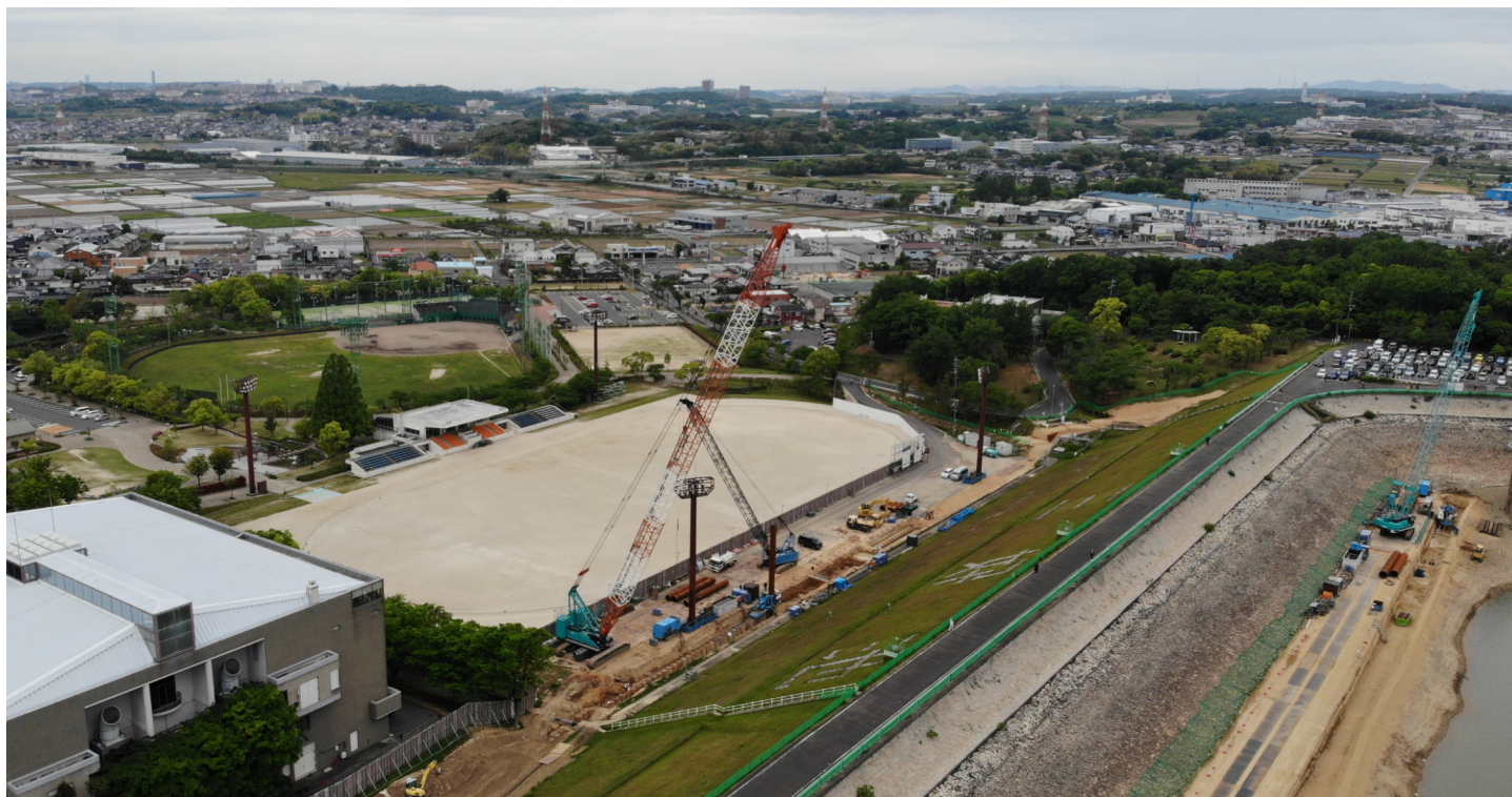
施工全景 堤内・堤外同時施工
