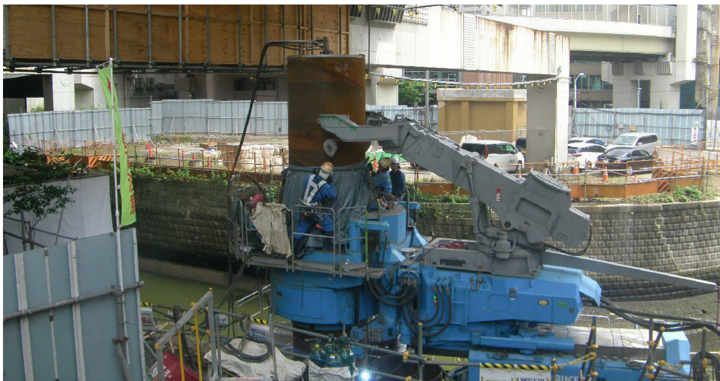
上空制限下：吊込み装置使用
