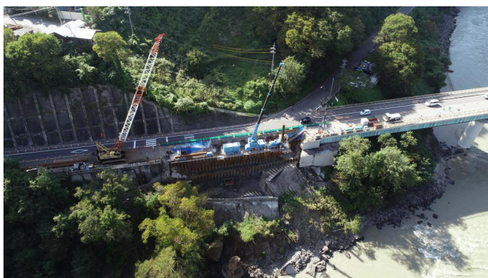
片側交互通行による施工
