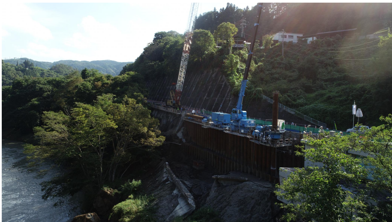
システム施工
