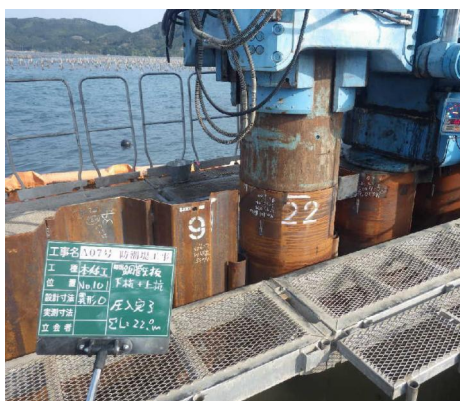
鋼矢板と鋼管矢板の嵌合
