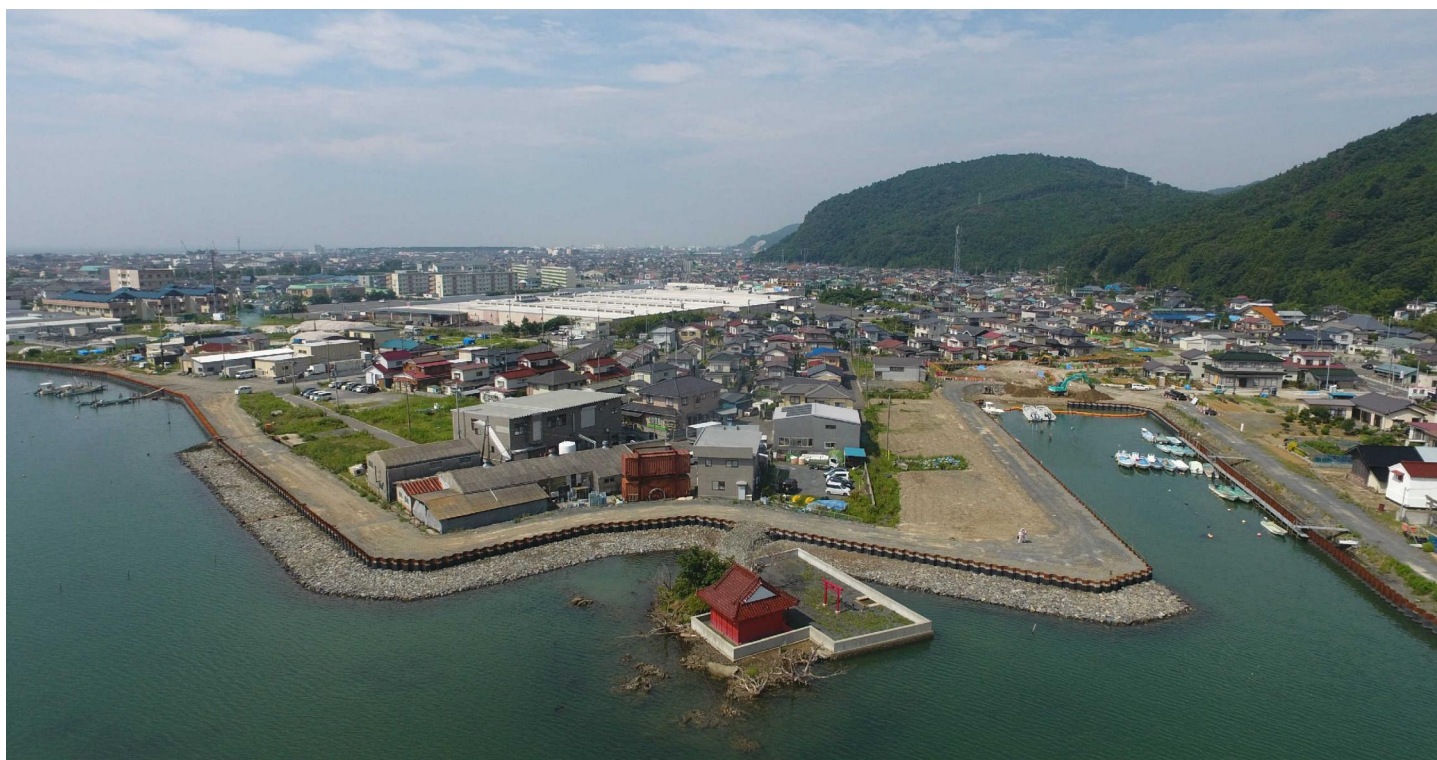
施工完了全景
