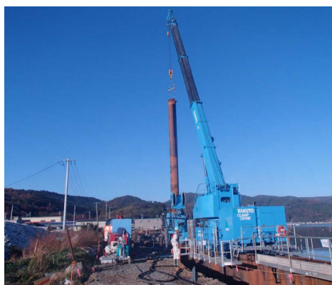
鋼管矢板GRB施工
