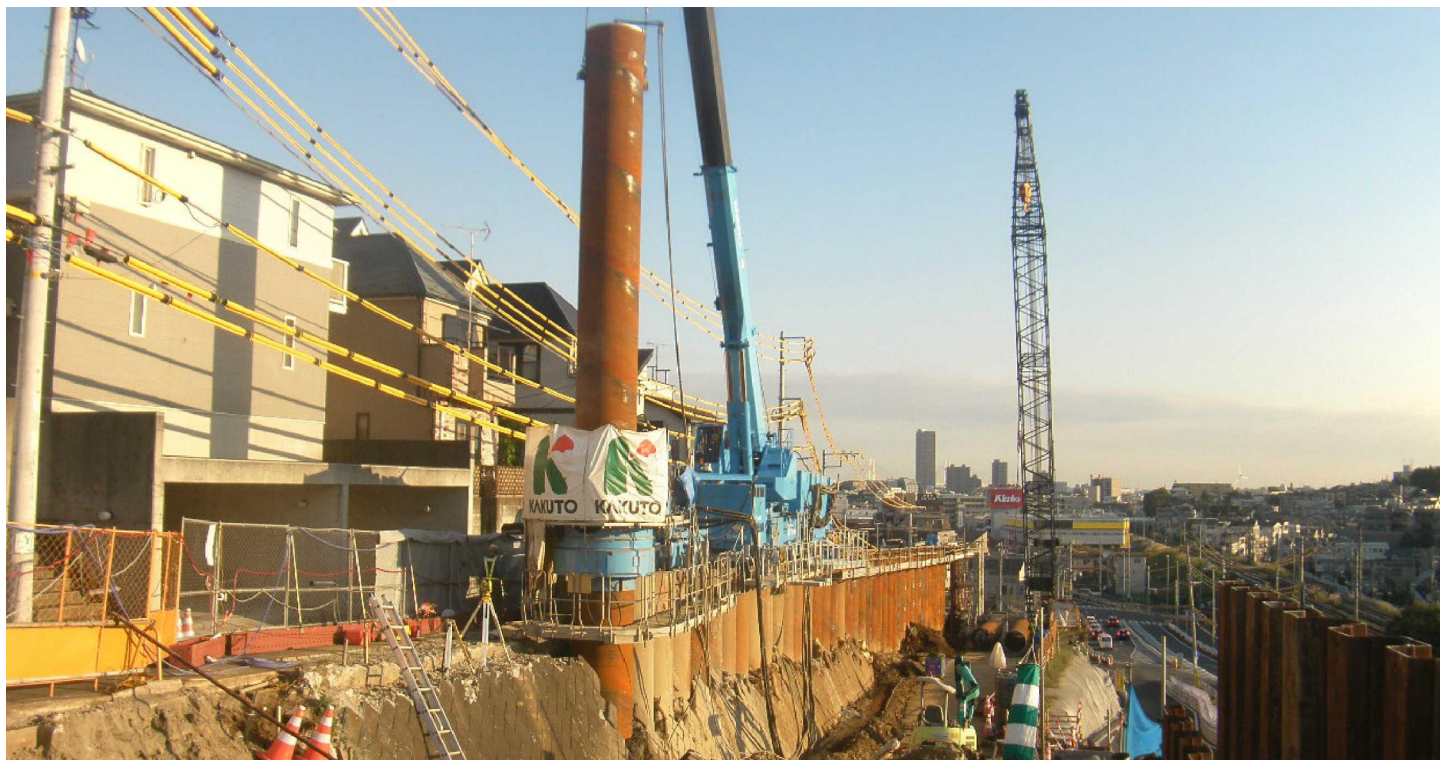
GRBシステム施工全景
