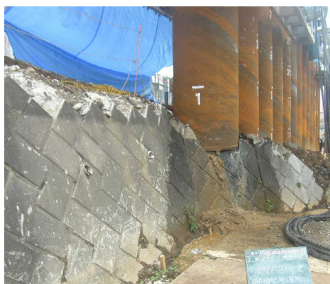
既設擁壁部圧入状況
