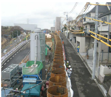
鋼管杭圧入完了
