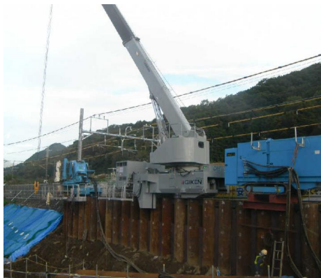
GRBシステム施工
