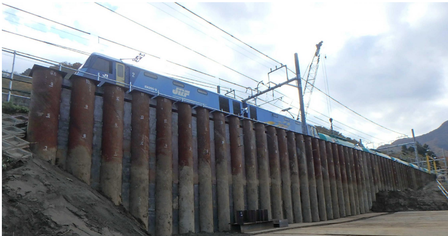
鋼管杭圧入完了
