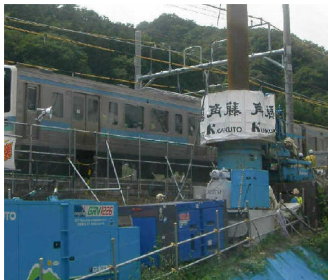
鉄道近接施工
