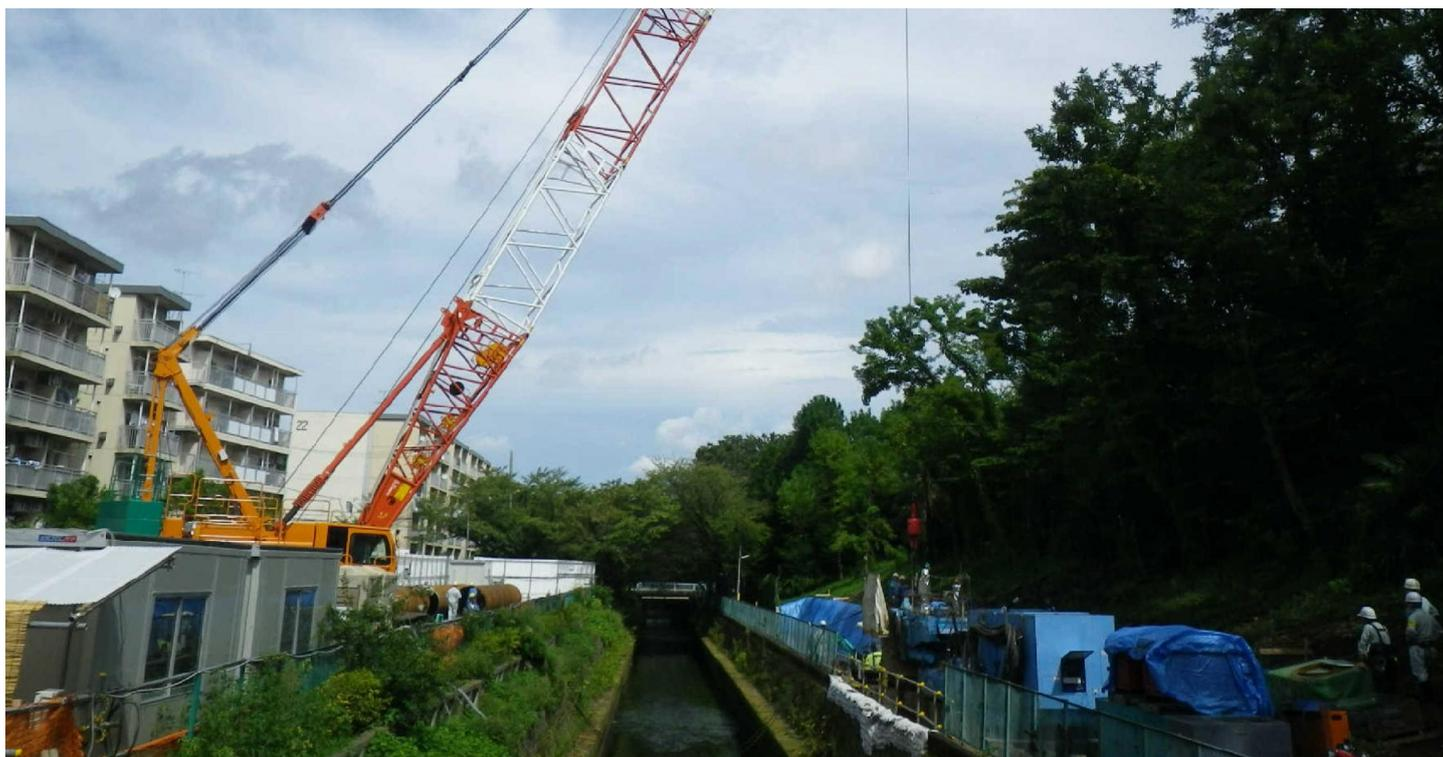
120tクローラークレーンにて鋼管杭建込み
