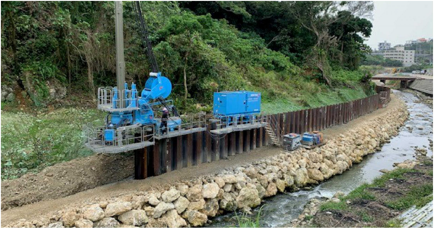
圧入施工状況
