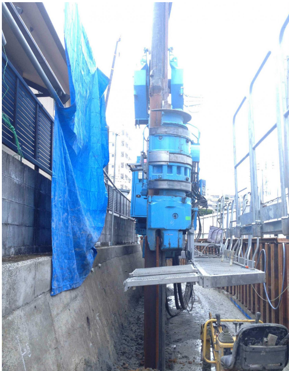
圧入施工状況
