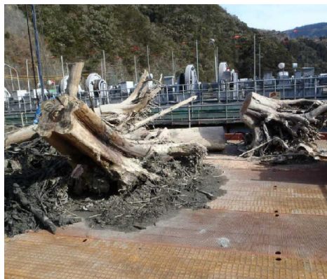
撤去作業により回収された巨木
