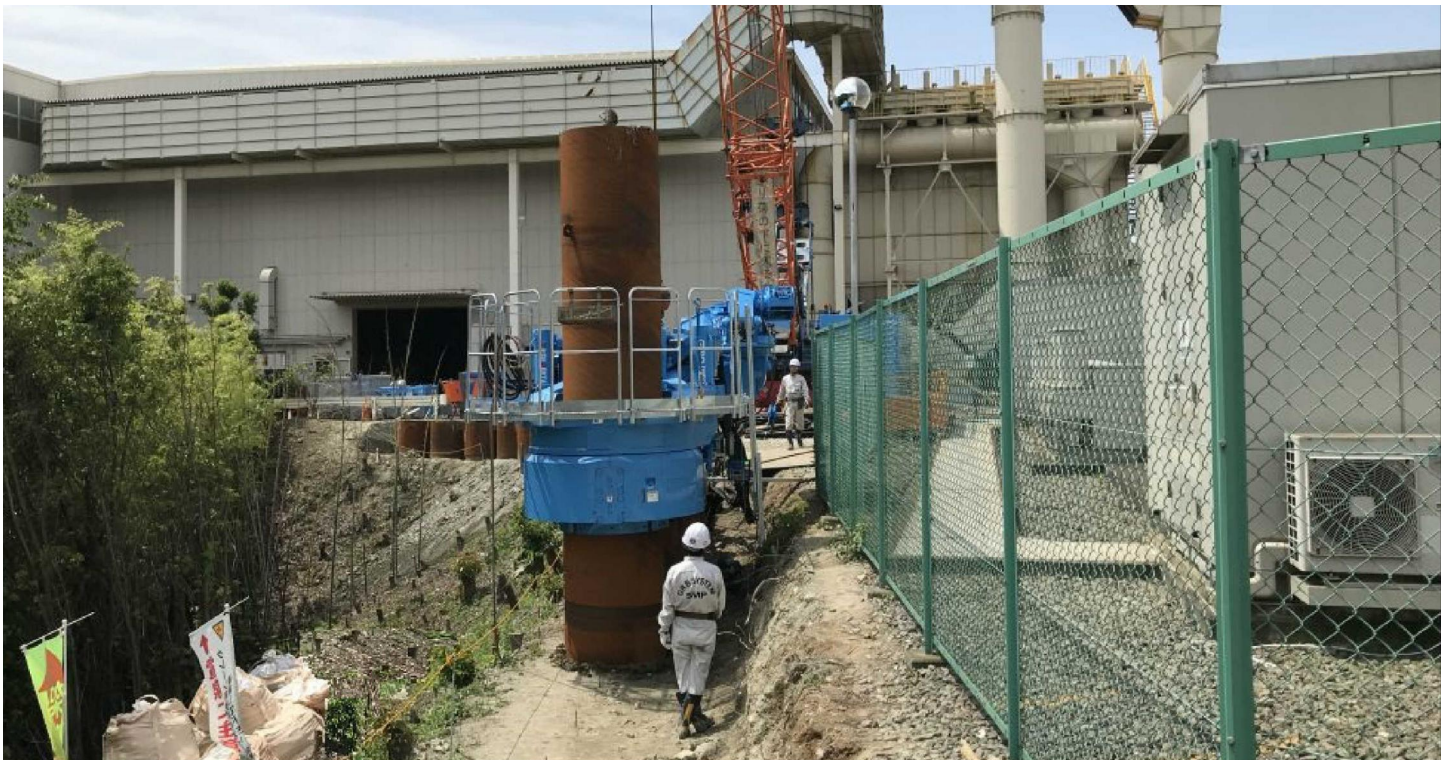
圧入状況① SP6使用区間
