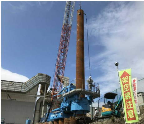
圧入状況② SP12使用区間
