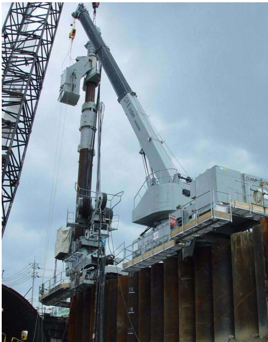
下り線-クランプクレーン使用
