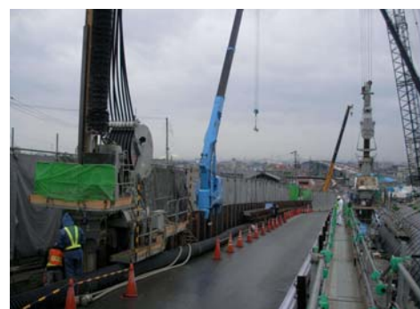
下り線(側道部)-鋼矢板施工
