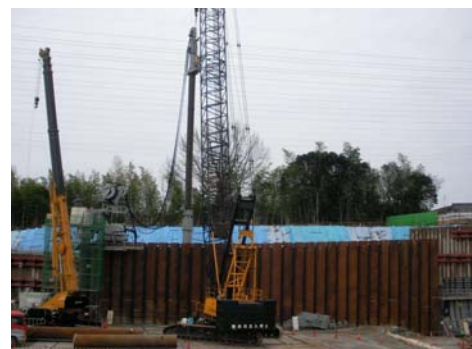
上り線-8.0m以上の高天端施工
