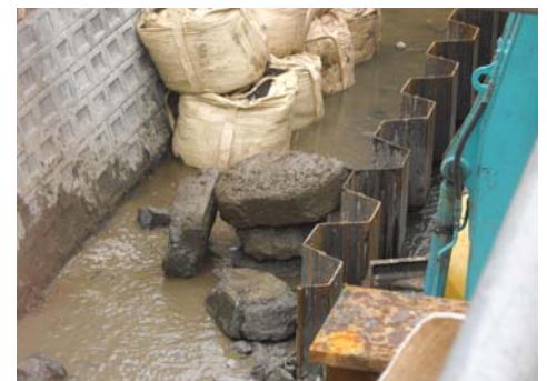
▲先行削孔でくり抜いた既設コンクリート護岸
