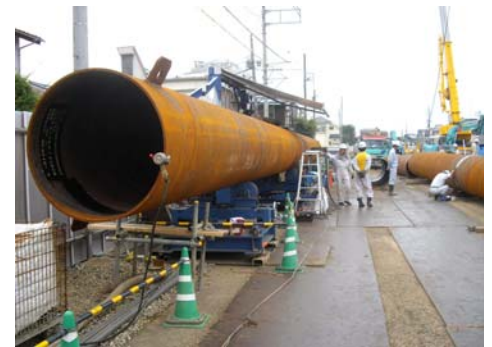
▲鋼管杭横継状況
