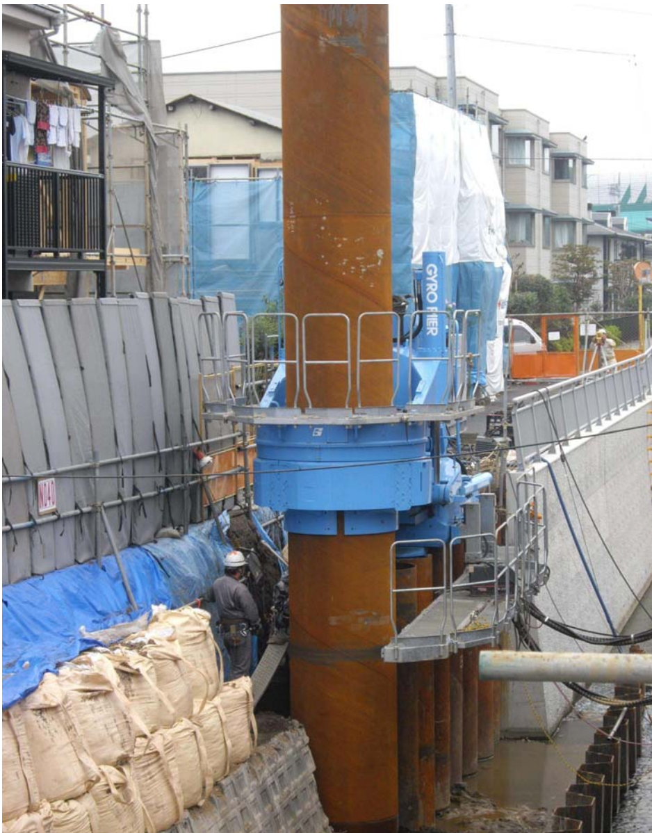
▲鋼管杭圧入状況
