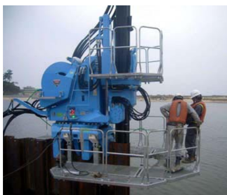
ステージによる作業員の足場の確保
