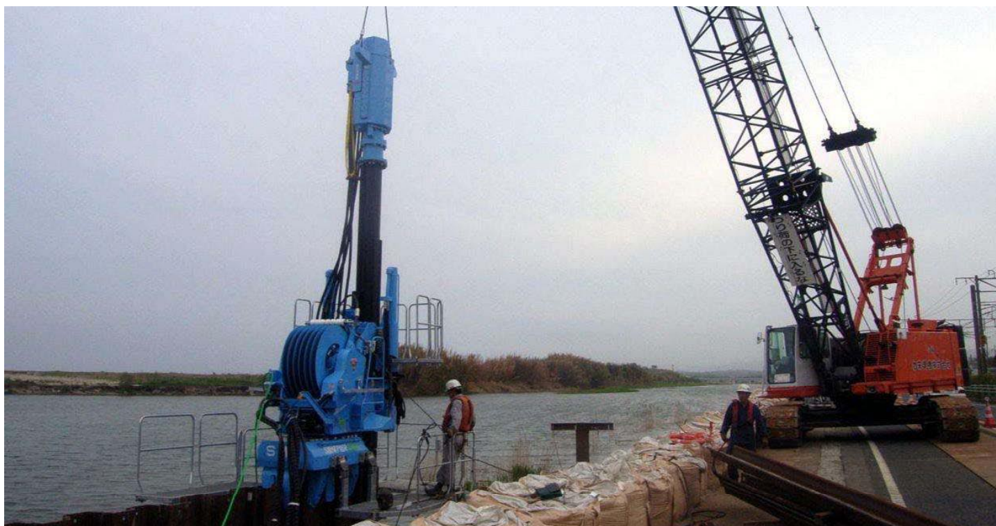
パイラオーガ併用による硬質地盤クリア工法
