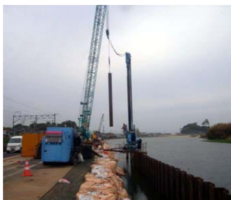
コンパクトな機体で最小限の一車線規制で施工
