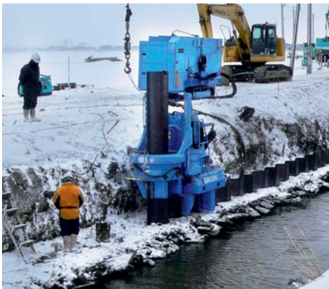
▲ コンパクトに改良された圧入機本体 ▲ 圧入機自走工程
