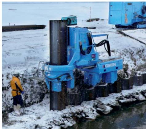
▲ コンパクトに改良された圧入機本体 ▲ 圧入機自走工程
