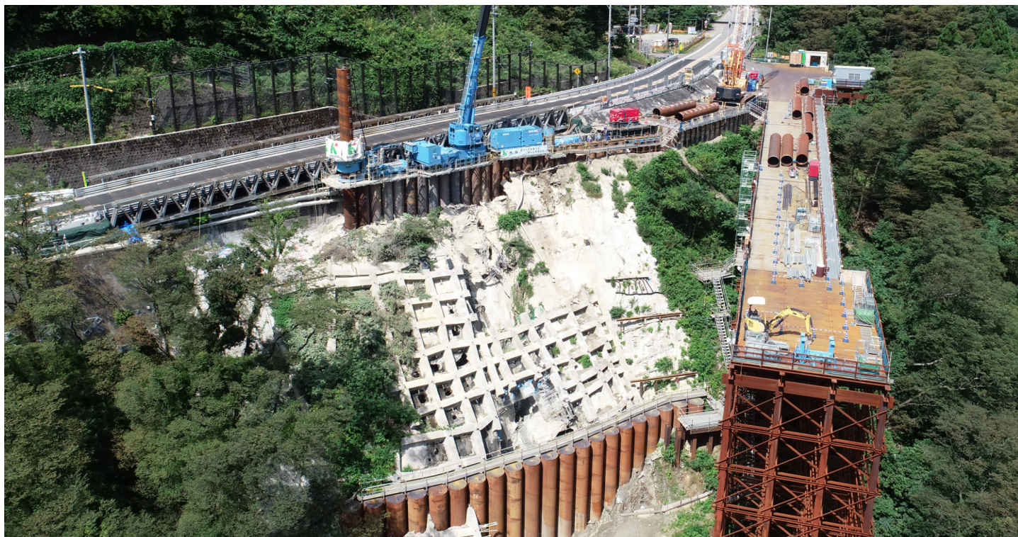
上段部 システム施工状況
