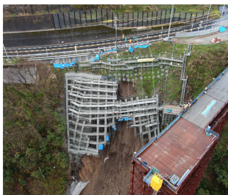
法面崩落災害発生直後
