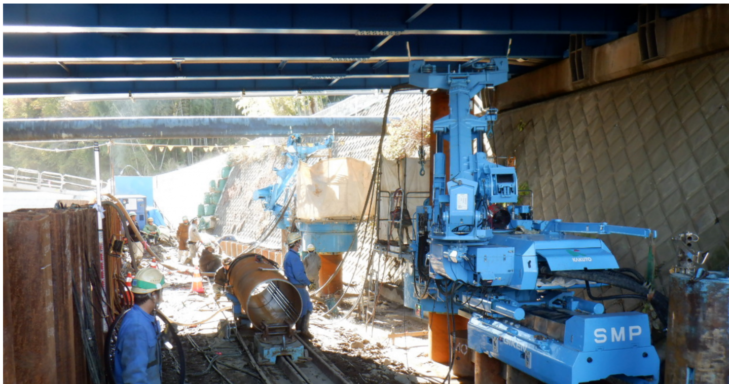
2台施工により工程短縮
