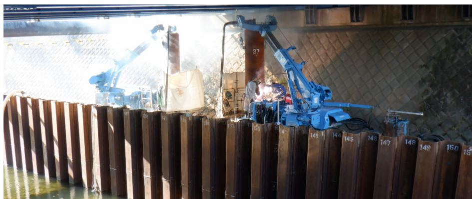
仮締め切り内上空制限下での施工
