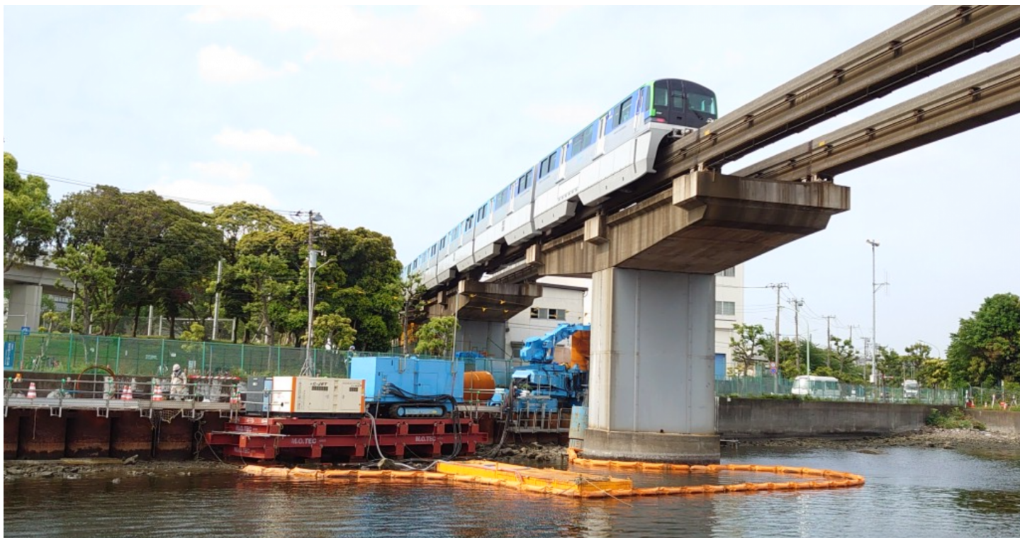
モノレール下部施工状況
