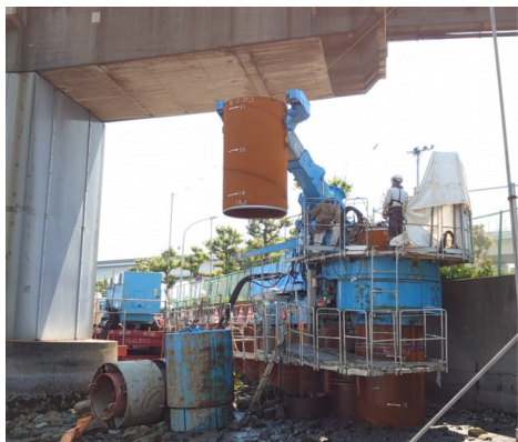
吊り込み装置による鋼管杭建込み
