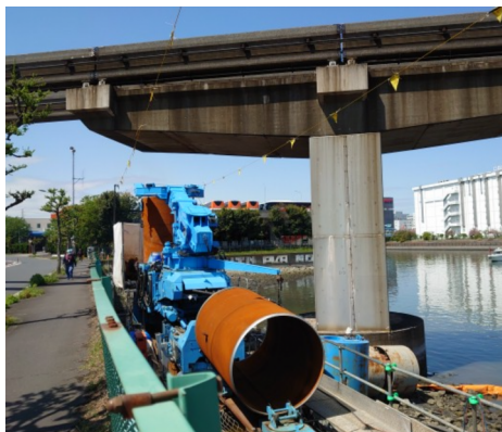
機械後方より鋼管杭搬送
