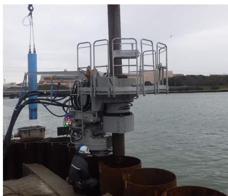
φ318.5小口径鋼管杭圧入
