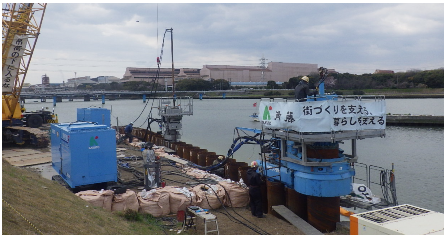
ジャイロパイラーと小口径パイラーによる並行作業
