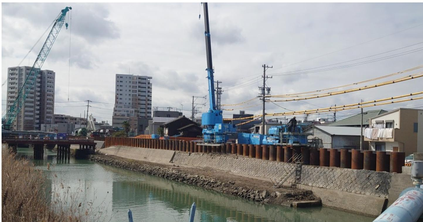
最小限の仮設構台によるシステム施工
