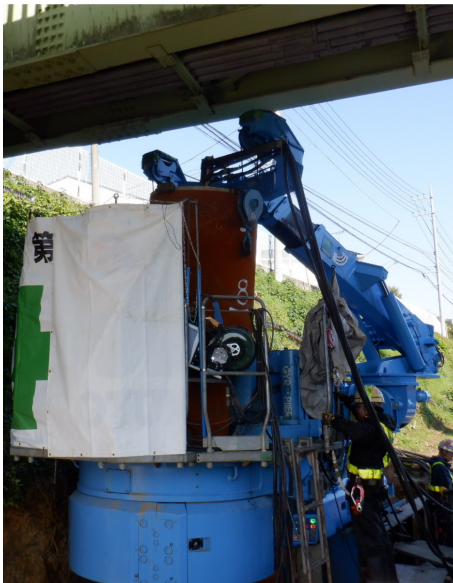
4.5mの上空制限下での圧入施工
