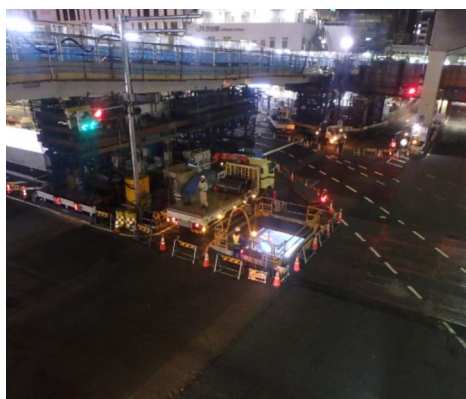
夜間規制帯内から杭材荷下ろし作業
