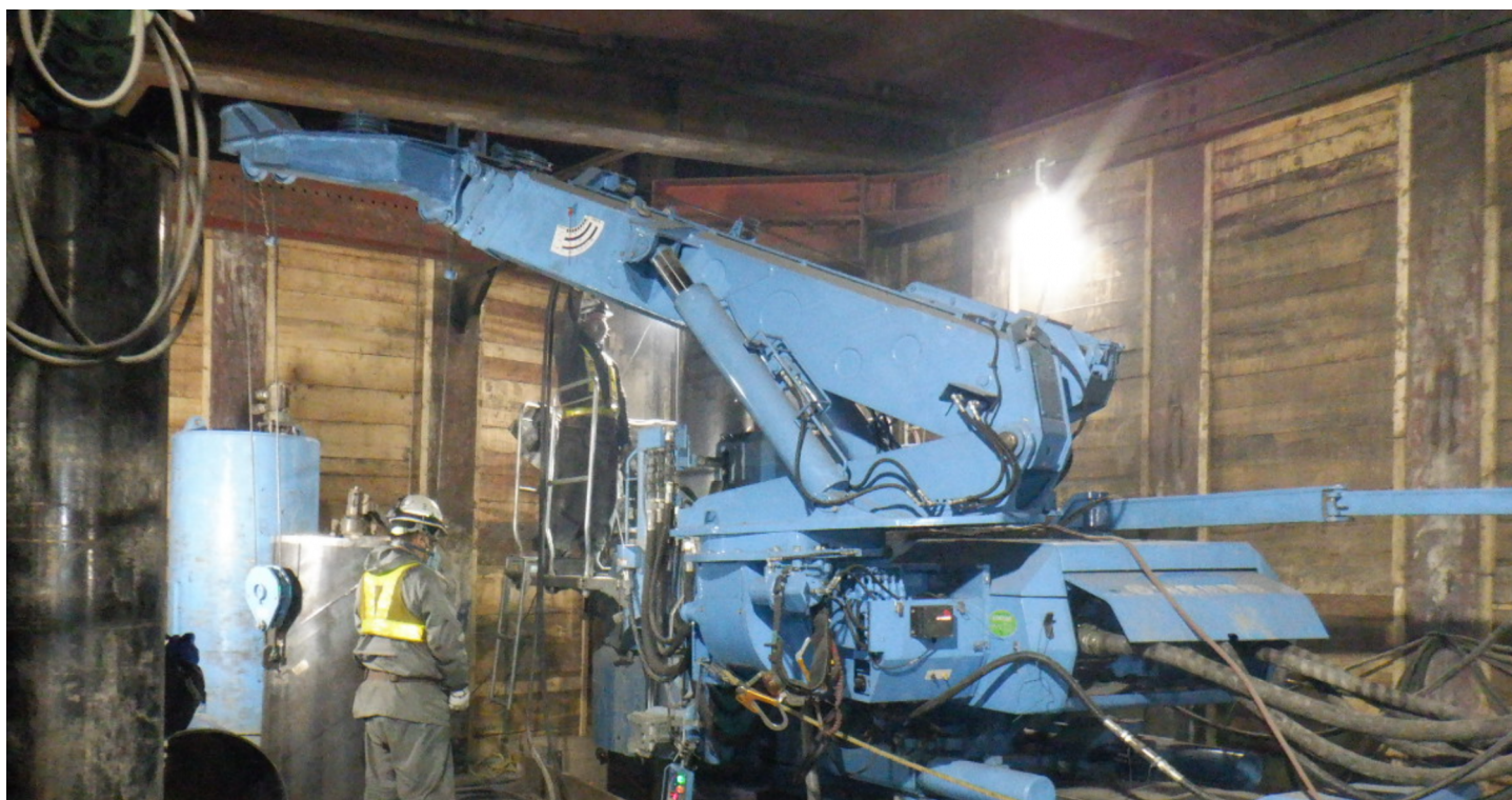
覆工板下で締め切り内の限られた施工空間での施工
