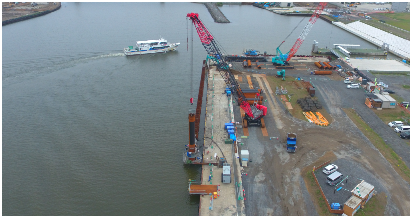
工事全景：別ラインにて2台同時施工実施
