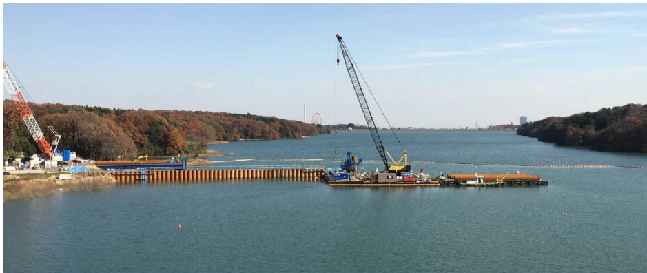
多摩湖内で環境へ配慮し、鋼管矢板で締切施工
