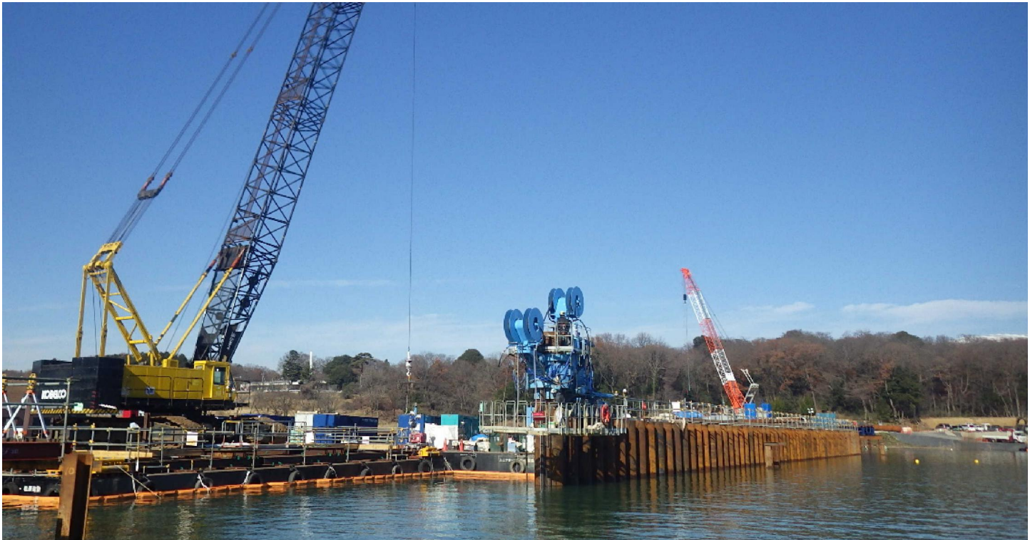
最大N値100の粘土混り砂礫層へウォータージェット併用鋼管矢板圧入状況
