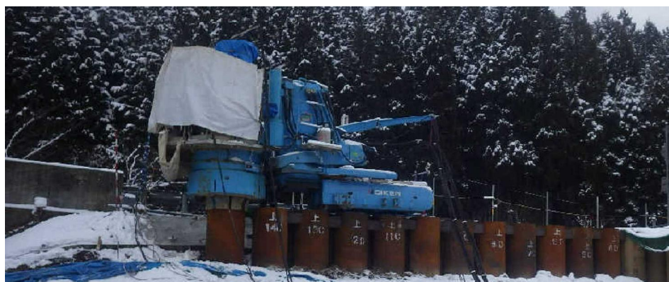
供用中高速道路本線近接施工
