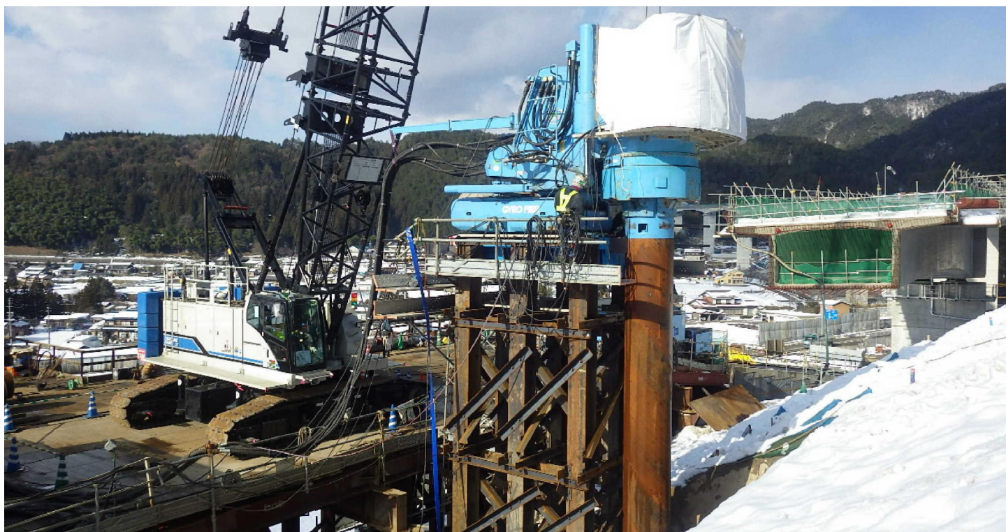
6m高天端施工 H鋼反力杭採用
