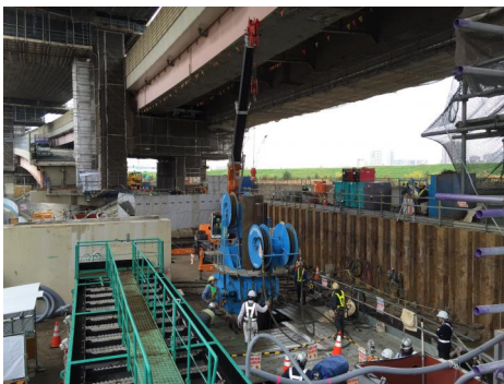
首都高桁下施工
