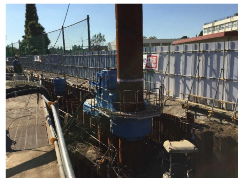
右岸2期施工 (SP5)
