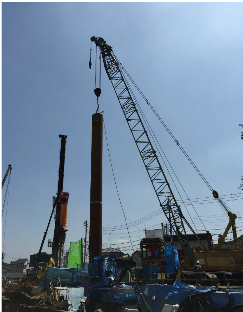
左岸1期施工 (SP12)
