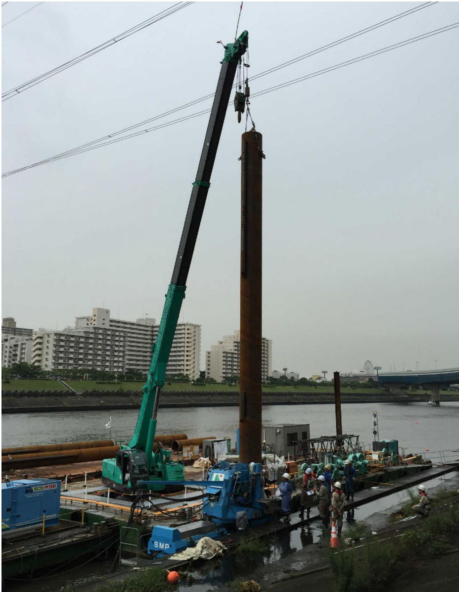
伸縮ジブクレーンにて施工効率UP
