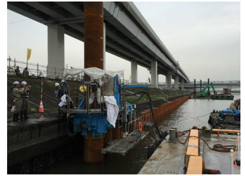
現場溶接にて継杭施工が可能
