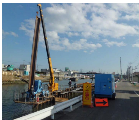
車道確保しながらの施工状況
