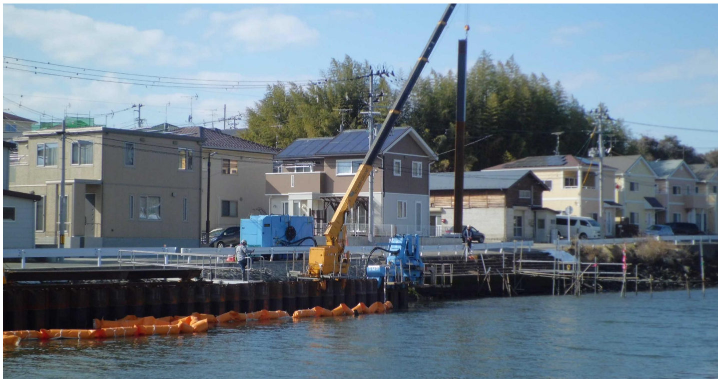
システム施工による施工状況
