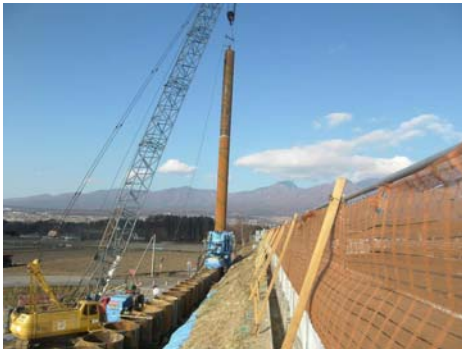
右側供用中の上信越道
