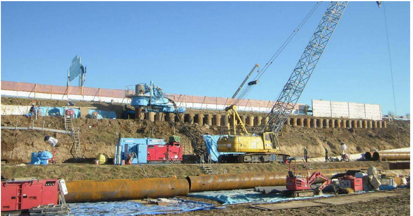
▲鋼管杭圧入施工中
