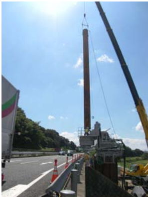
国道25号(名阪国道)近接作業
