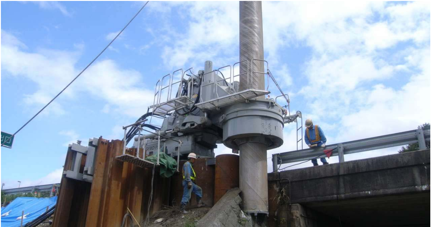
既設石積み撤去状況
