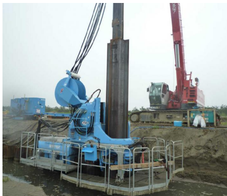
水上施工を可能とするパイラステージ装着
