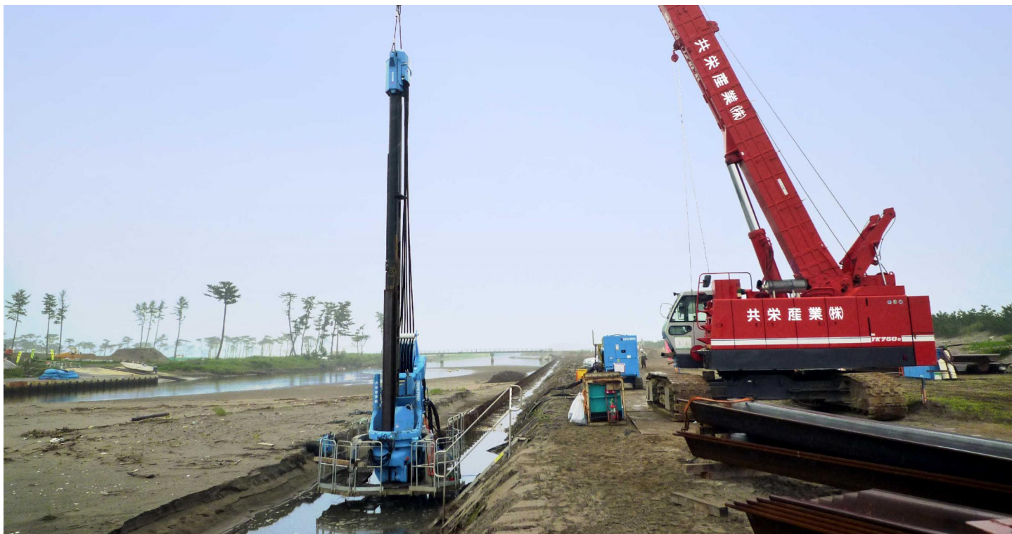
ハット形鋼矢板圧入施工状況
