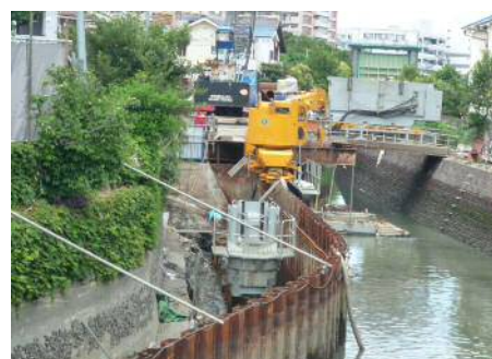
▲ 締切り内での圧入機の作業状況
