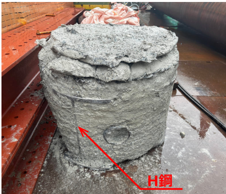
▲ 障害物削孔後、取出し状況(H600×300)
