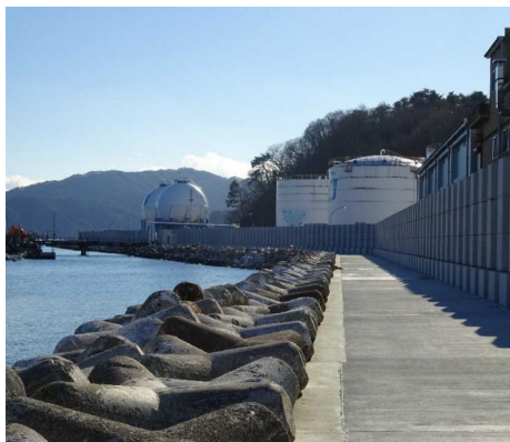
CSW (プレキャストブロック) 設置完了
