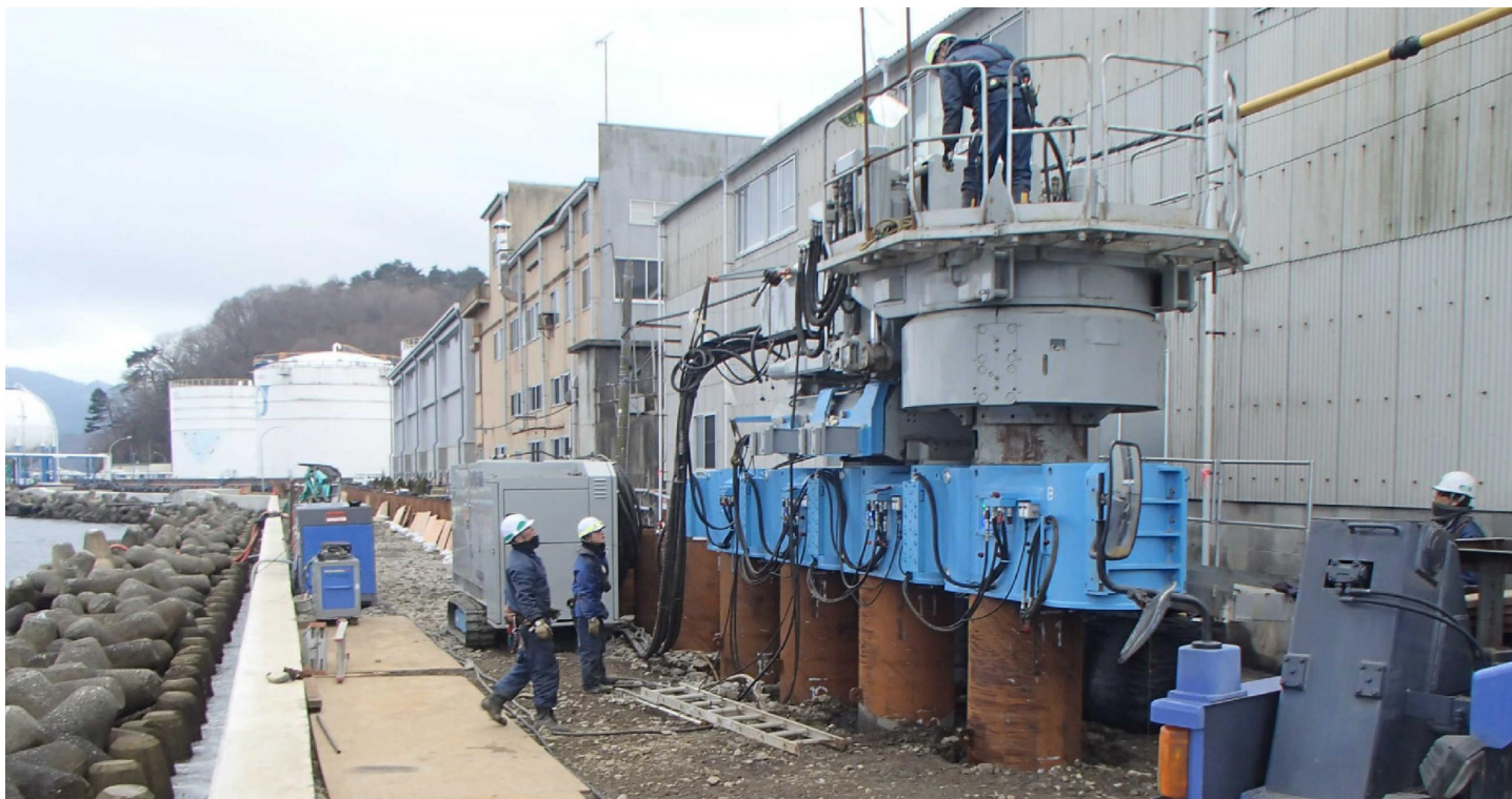
スキップロックアタッチメント使用による施工
