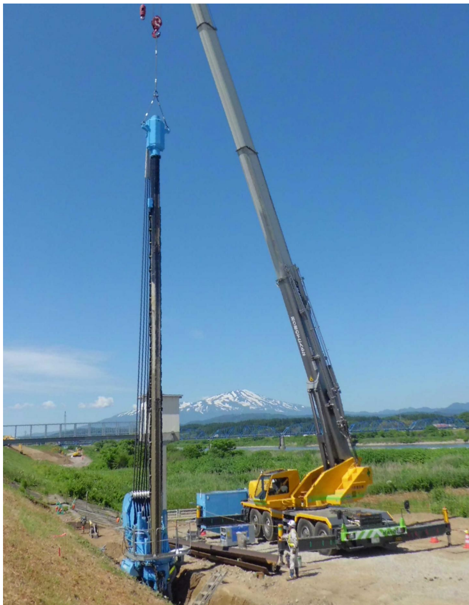
圧入施工状況
