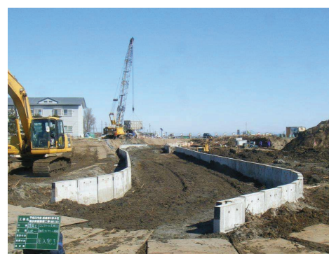
▲圧入後、掘削作業時
