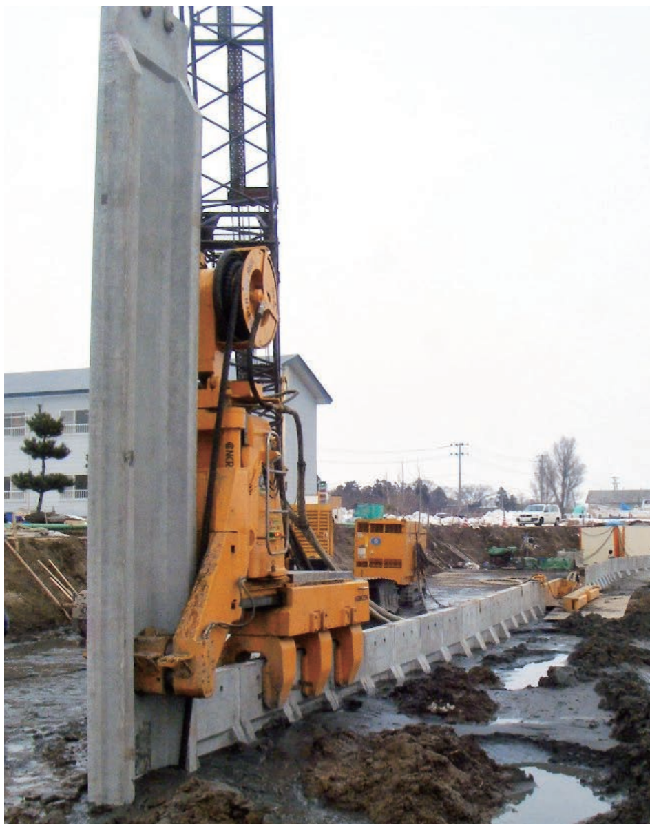
▲コンクリート矢板圧入施工時
