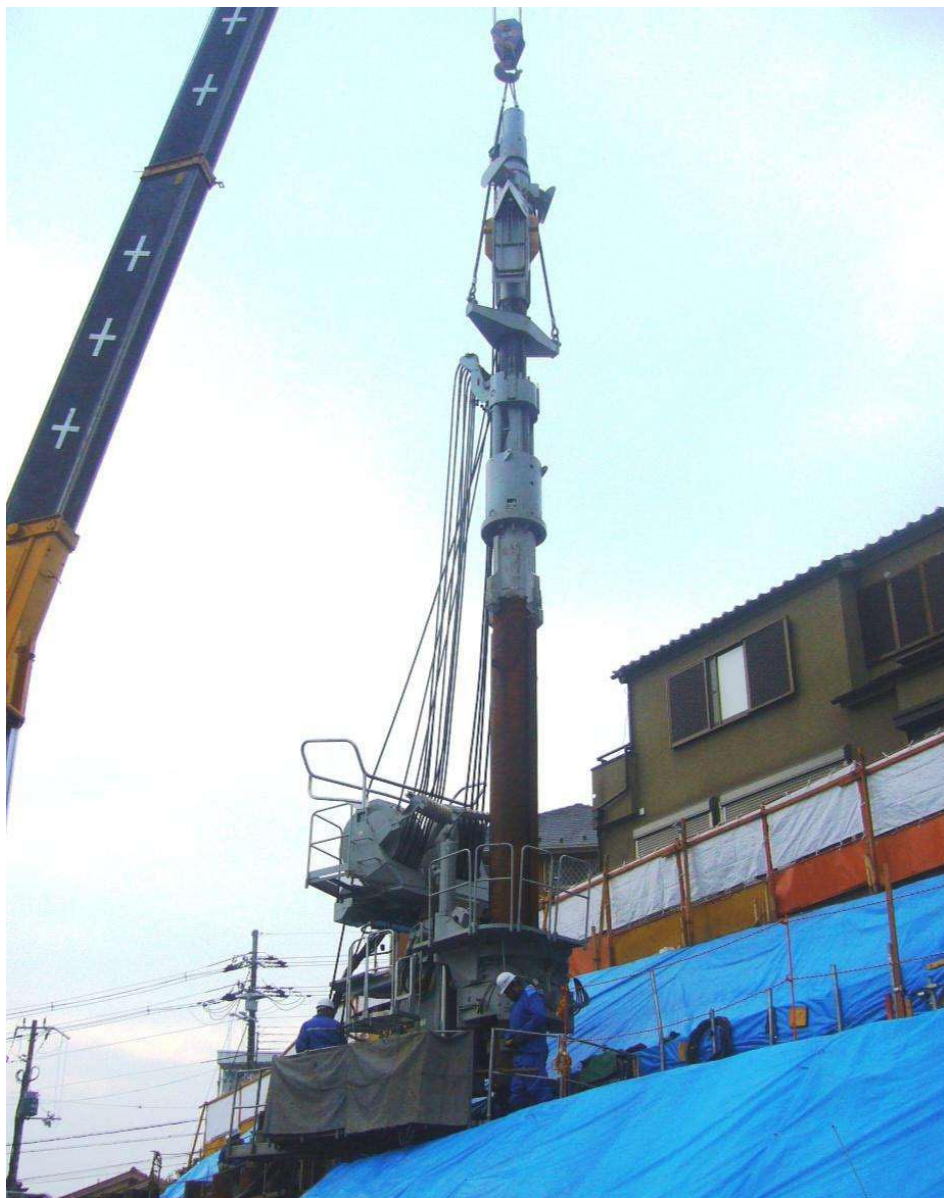
圧入施工(硬質地盤クリア工法)
