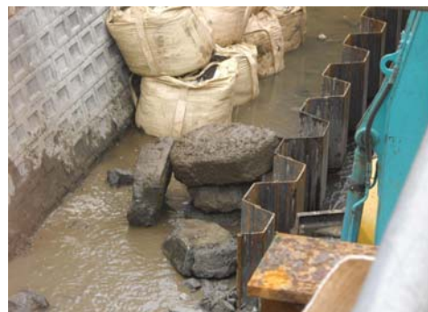
▲先行削孔でくり抜いた既設コンクリート護岸
