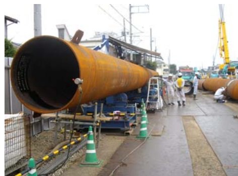
▲鋼管杭横継状況
