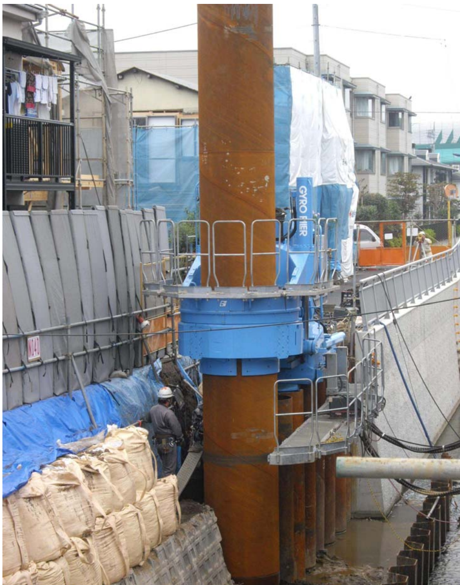
▲鋼管杭圧入状況
