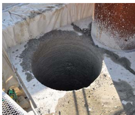
既設橋台先行削孔状況
