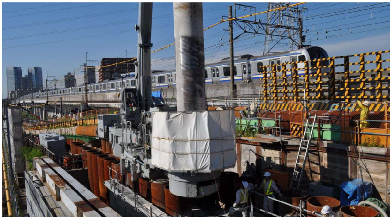
ジャイロパイラーによる回転圧入状況
