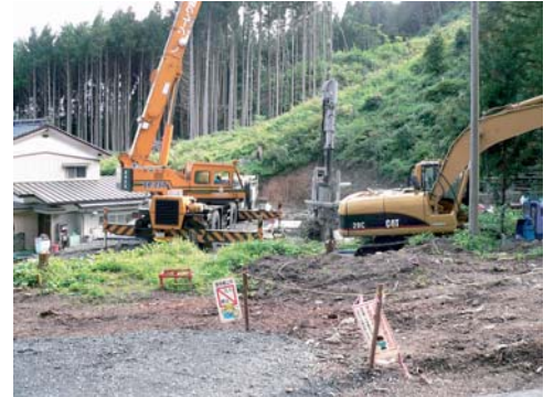
▲ 施工位置には民家が隣接
