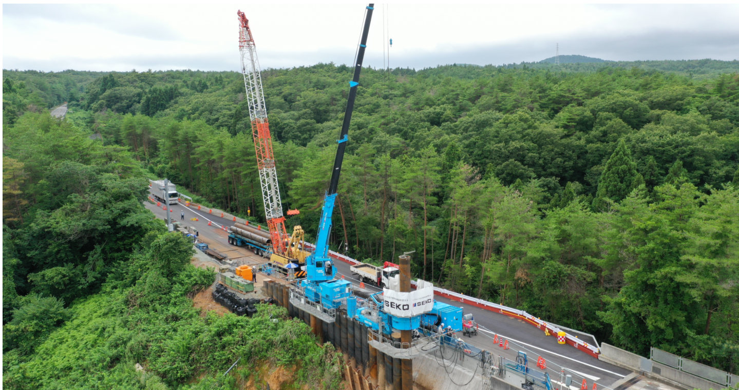
▲システム施工
