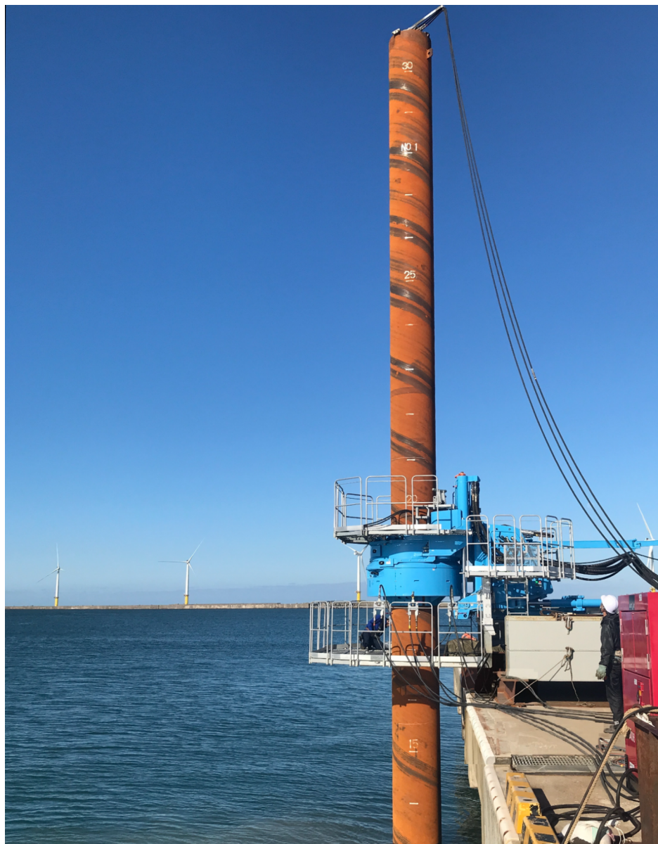
初期圧入状況
