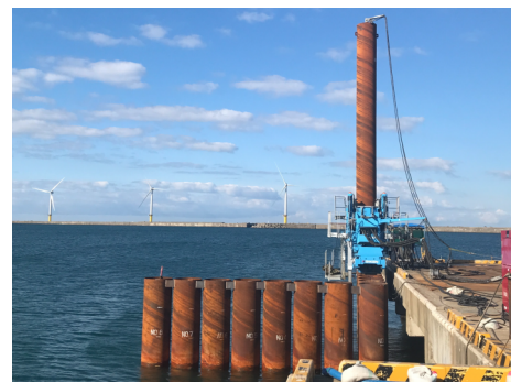
既設栈橋近接施工
