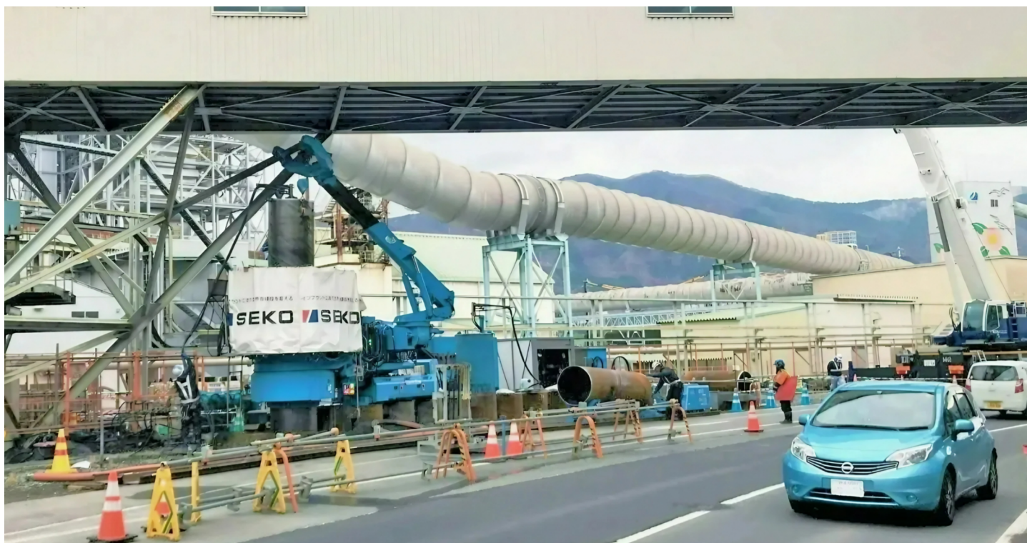
▲施工状況(空頭制限区間)
