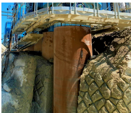
既設コンクリート護岸を削孔
