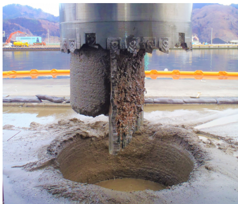
▲先行削孔でくり抜いた鉄筋コンクリと軽量鋼矢板
