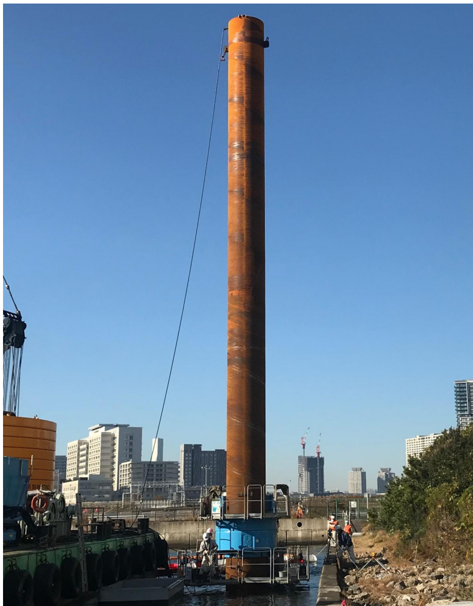
鋼管杭圧入状況
