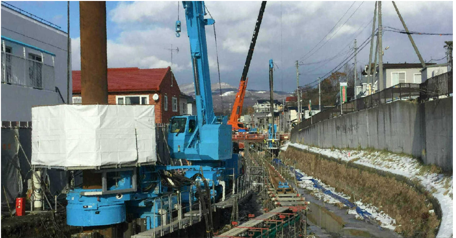
2台同時システム施工
