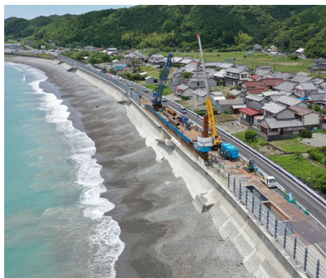
施工状況(全景)
